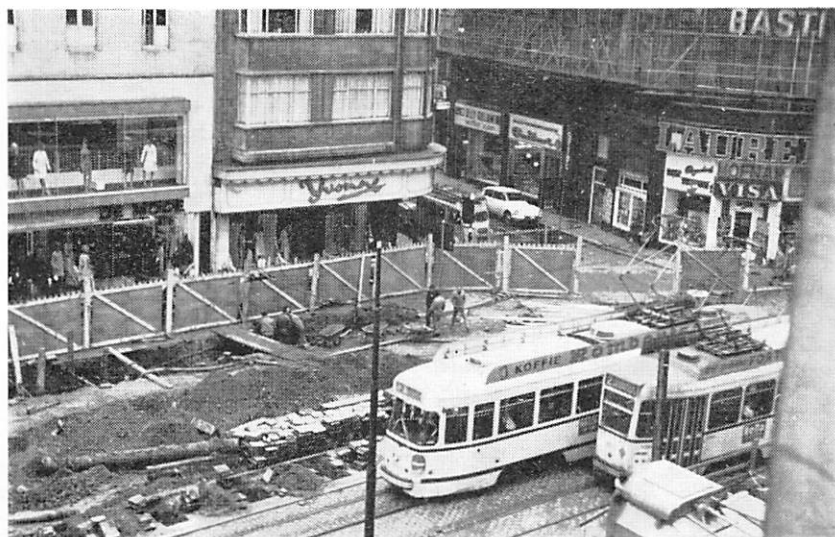
PRE-METROWERF TENIERSPLAATS — TOESTAND OP 9.4.1970.
